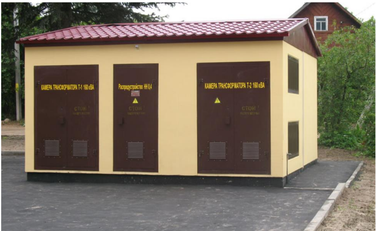
Рис. 5 Двотрансформаторна КТП «кіоскового» типу
