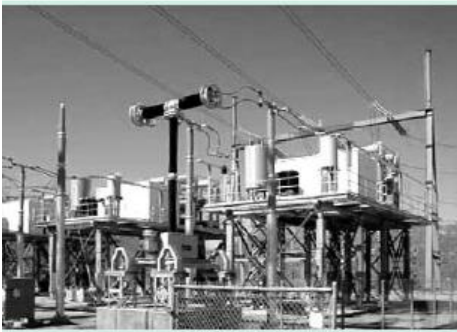
Рис. 6.7. Установка поздовжньої компенсації з тиристорної захистом TPSC на підстанції 500 кВ Vincent (енергокомпанія Південної Каліфорнії)
